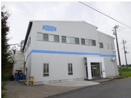
마쓰이제작소 우라와산업 사업부의 사옥
