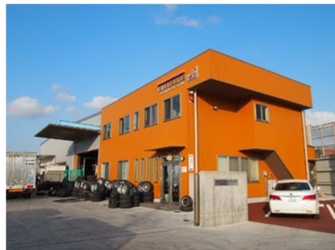
約2800平方メートルの敷地に本社専務所を移転新築した。
